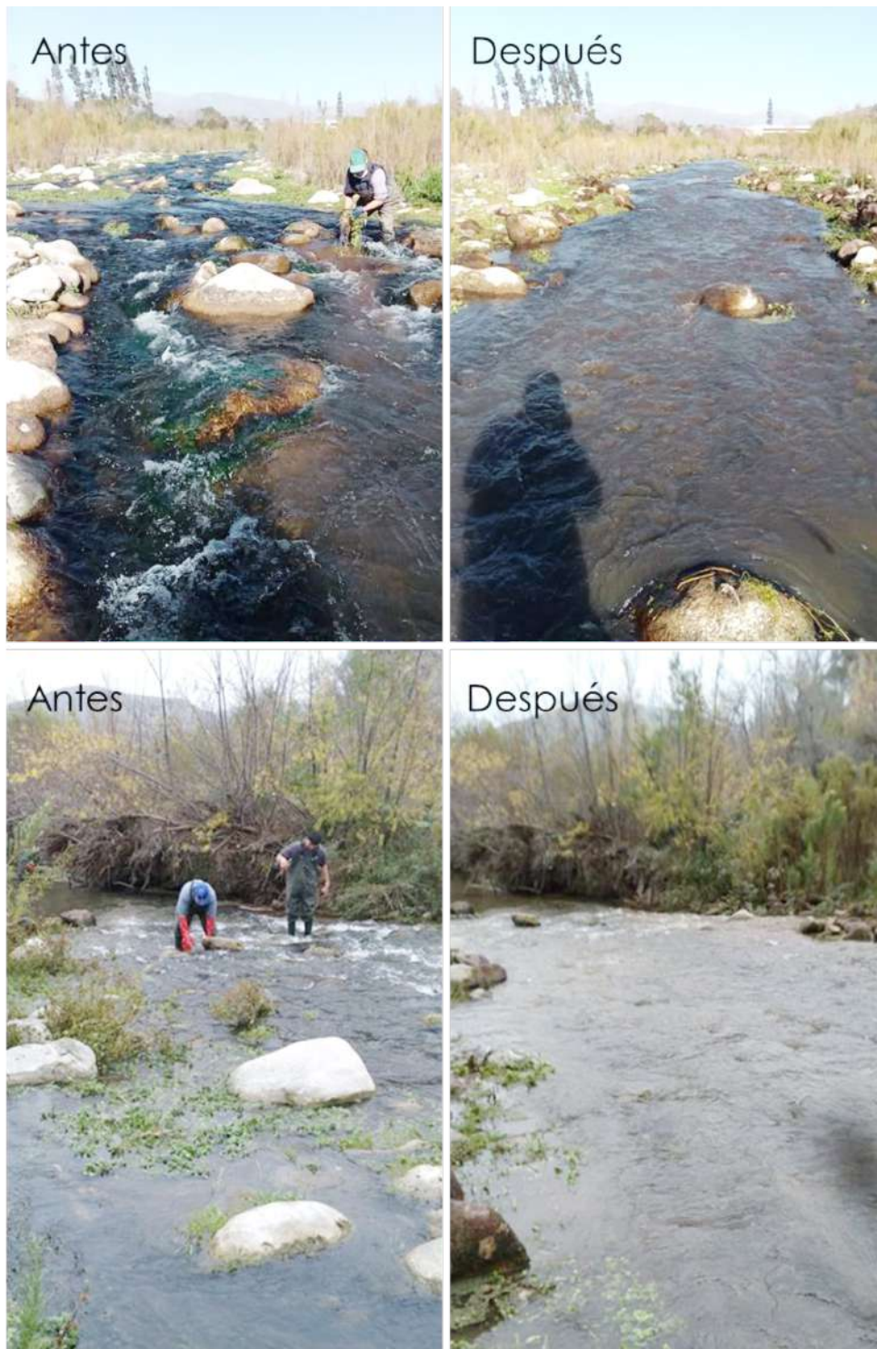
Figura 49. Trabajos de encauzamiento y manejo de camarones realizados por las organizaciones de camaroneros del Choapa en las áreas de intervención. Nótese la homogenización del cauce fluvial después de la intervención manual de la obra.
