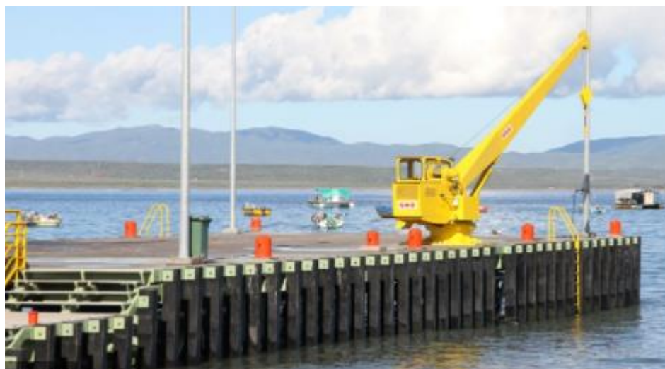
Figura 123. Infraestructura pública de apoyo a las faenas de cultivo. Fuente: (GORECOQUIMBO, s.f.).
